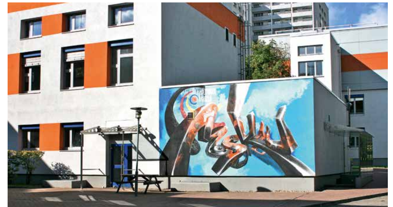
Die Deutsche Schule Moskau liegt mitten in einem Wohngebiet und sticht durch farbenfrohe Malereien und bunte Hauselemente hervor.
