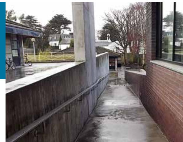
Bauliche Maßnahmen an der DS Dublin: Die Rampe erleichtert Rollstuhlfahrern den Zugang zum Schulhof.
