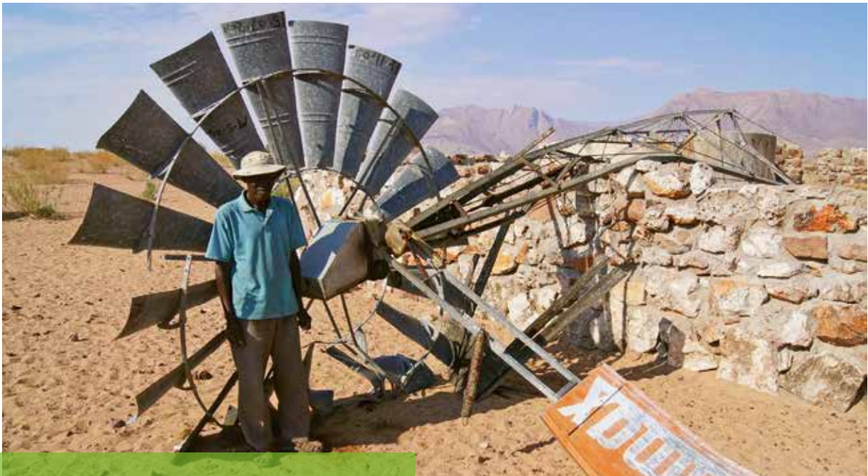
Im Nordwesten Namibias setzten Schüler der DHPS die einzige Grundwasser pumpende Windmühle der Region wieder instand, nachdem sie von Elefanten zerstört worden war.
