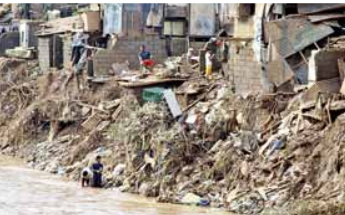
Der Taifun richtete schwere Schäden an Gebäuden und Straßen an: hier eine abgerutschte Slumsiedlung am sogenannten Floodway.
